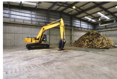
千葉RC内保管ヤード
