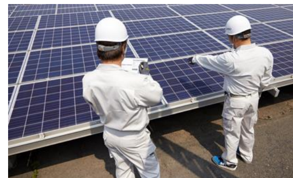
定期的なメンテナンス
