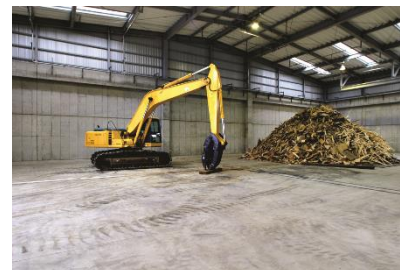
千葉RC内保管ヤード
